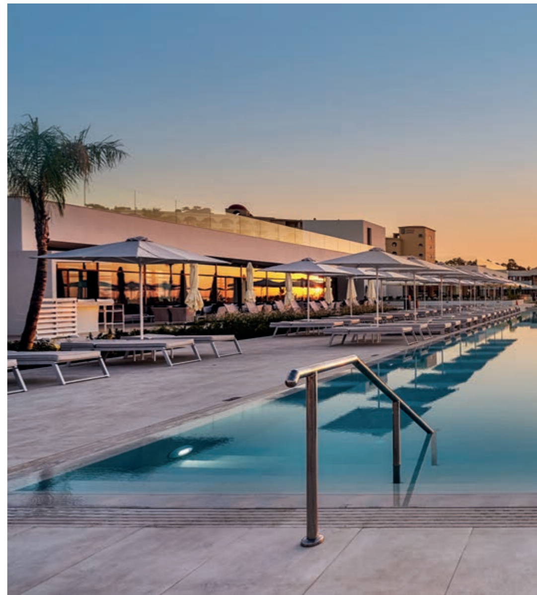
Las soluciones de drenaje con la RJ67 junto al borde Hawaii, valor seguro.
